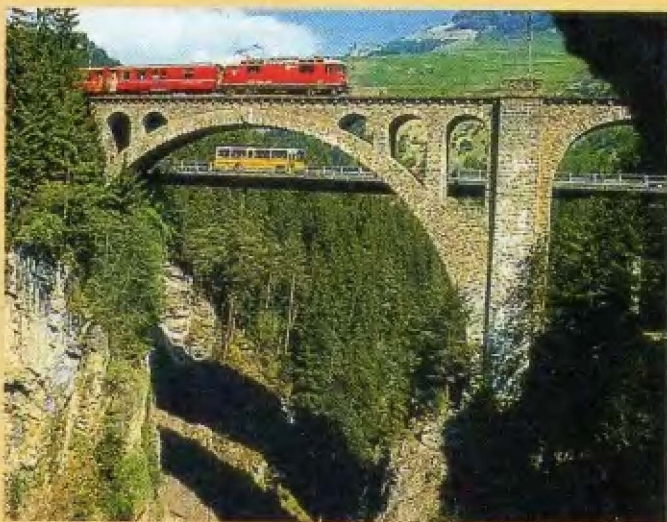
Старинный арочный мост через глубокое ущелье в Швейцарии. Сверху проходит железная дорога, нижнее полотно отдано автостраде.
