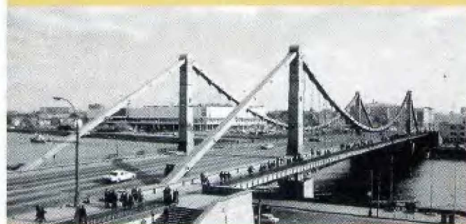
Крымский мост – единственный подвесной мост в Москве. Построен в 1938 году.
